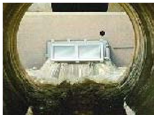
Abb. 23: automatische Schwallspülung für grosse Kanäle
