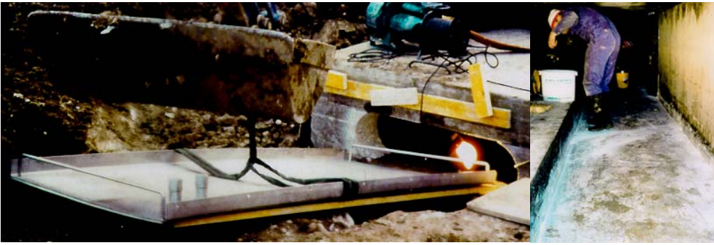
Abb. 17: Rinnenwärmetauscher für Kanäle mit Rechteckprofil
