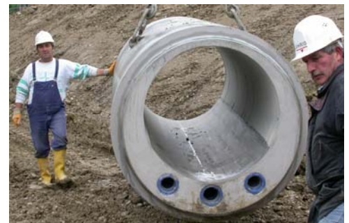
Abb. 21: Rinnenwärmetauscher als vorgefertigte Kanalisationselemente
