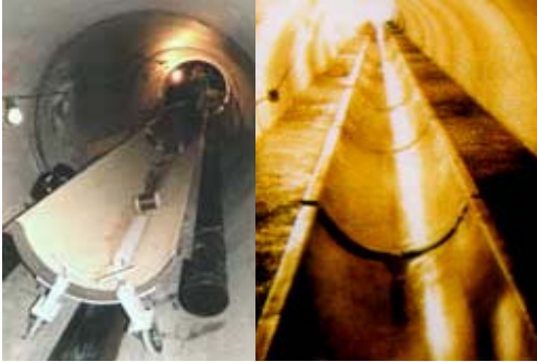
Abb. 5: Der 200 m lange Wärmetauscher vor und nach dem Eingiessen im Kanalisationsrohr in Wipkingen
